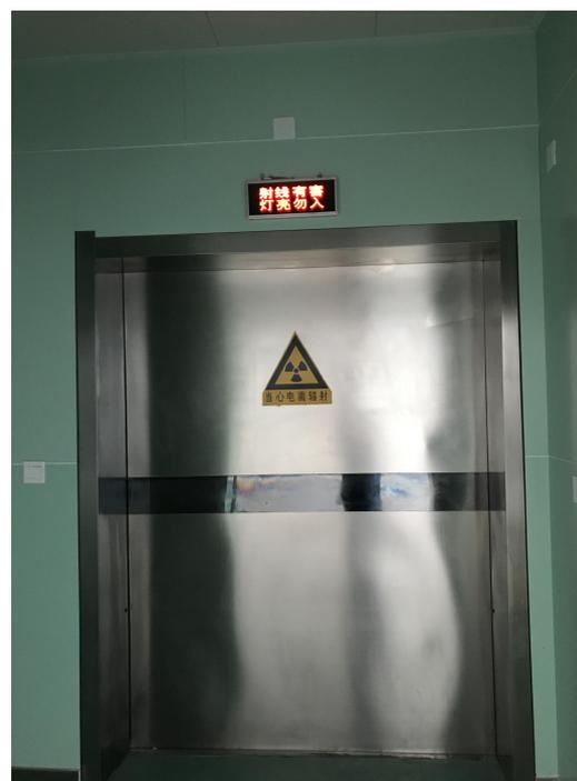
图 3-14 电离辐射警告标志及工作状态指示灯
